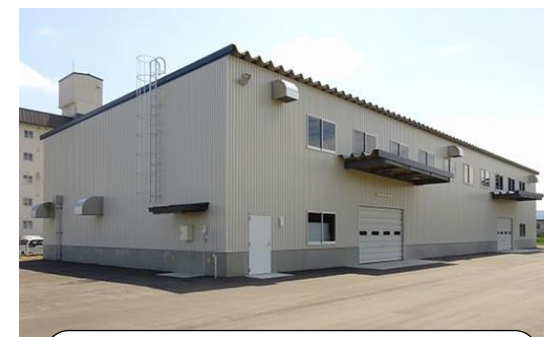
令和4年3月に完成した拠点備蓄倉庫
